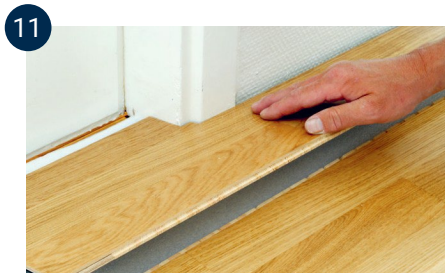
Seejärel paigaldage viimane laud lõõgirauga küljelt. Viimistlemiseks asetage põranda ja seina vahelisse paisumisvuuki kiilud, et põrandal oleks pinget kuni liimi kuivamiseni. Nüüd, kui põrand on paigaldatud, saab paigaldada katteliistud ja põrandaliistud; ärge unustage kõiki kiile eemaldada.
