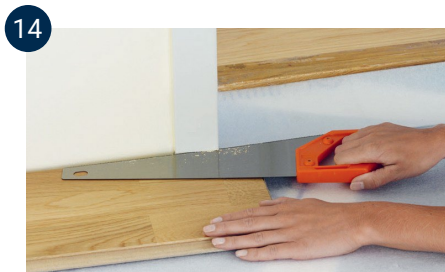
Ukselenge saab eemaldada ja üles tõsta, kuid tavaliselt on neid lihtsam ära saagida. Kasutage kõrguse mallina lahtist põrandalauda ja saagige leng ära. Veenduge, et põrand ei jääks väga tihkelt.
