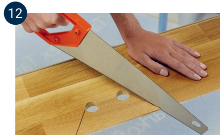
Kui plaadi pikem külg puutub kokku torudega, puurige auk, mille läbimõõt on vähemalt 16 mm suurem kui toru läbimõõt, nii et toru ümber oleks paisumisvuuk. Märkige pliiatsiga koht, kus soovite saagida. Saage ära detail, mis asetatakse torude taha, kõige lähemale seinale. Lõika nurga all, nagu pildil näidatud. Kui torud asuvad põranda lühemal küljel, lõigake laud 90° nurga all otse läbi aukude.
